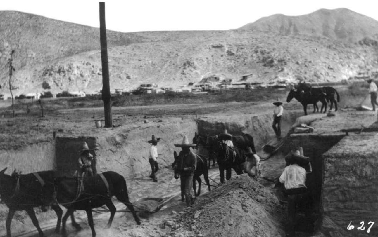
Figura 6. “Excavación del canal”, 1909
