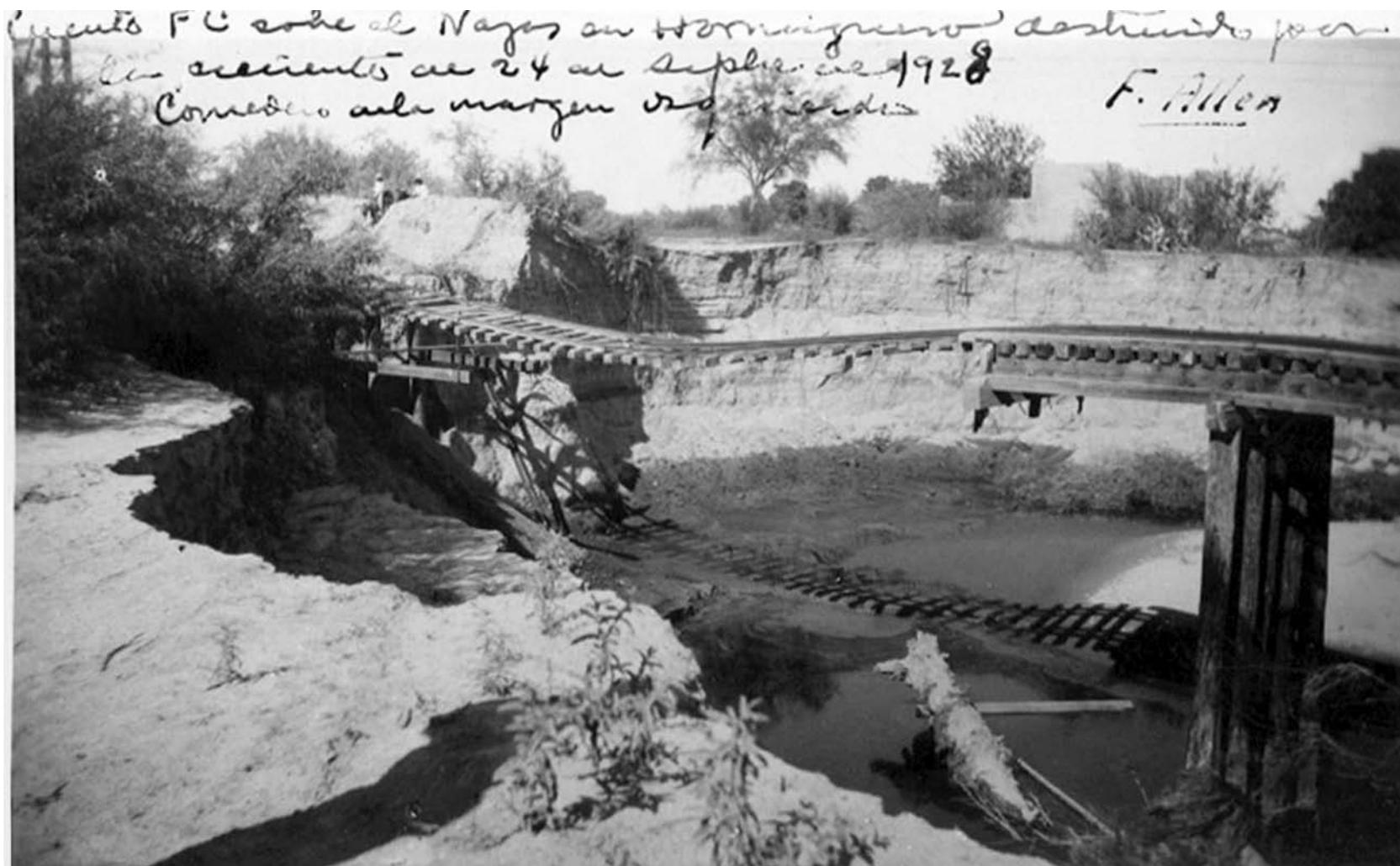
Figura 40. Fotografía tomada por el ingeniero Francisco Allen que muestra el puente de Ferrocarriles que pasaba sobre el sitio llamado Hormiguero, el cual había sido destruido por el crecimiento del río el 24 de septiembre de 1928 (Fuente: ANA, Fondo de Aprovechamientos Superficiales, Expediente 6034, Caja 250, Foja 5, Fotografía 01-0450, 24 de septiembre de 1928).
