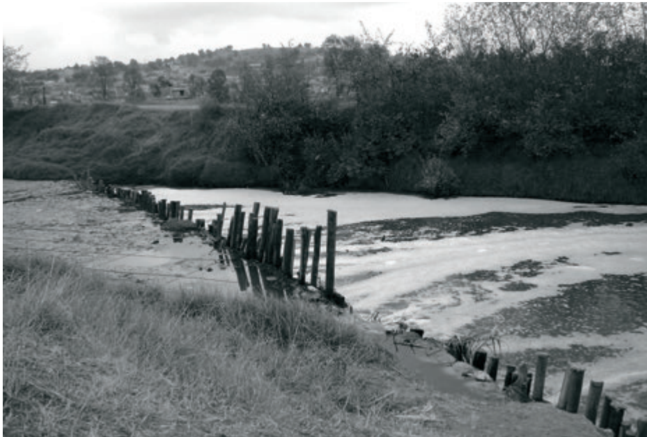
Fotografía 18. Presa del ejido de Tepactepec, río Zahuapan.
