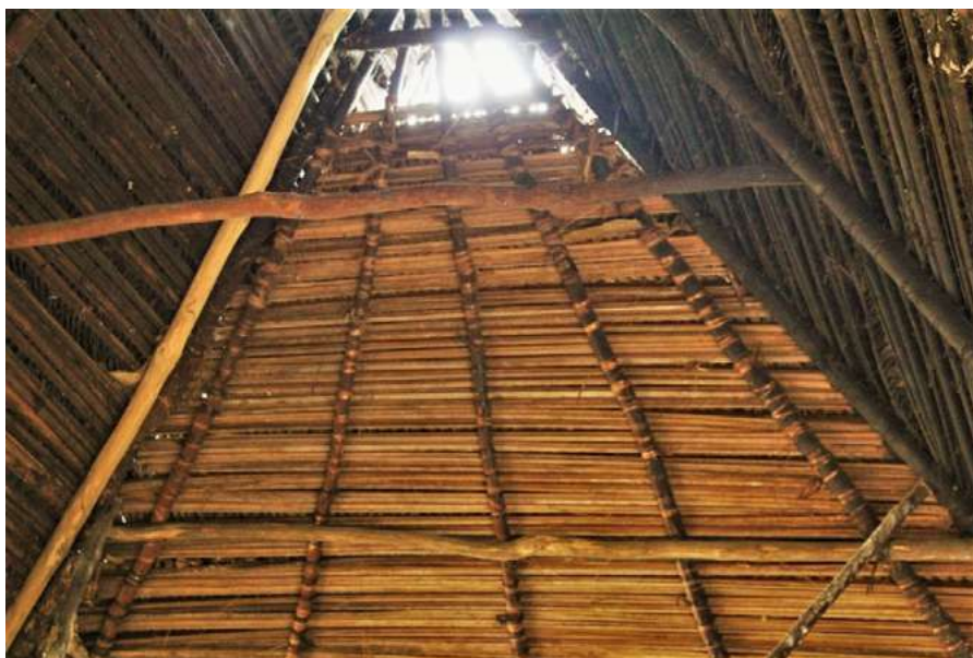
Imagen 4. Amarrado interior del techo de palma bröran
