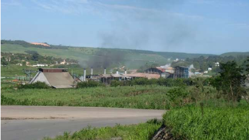
Fotografía 1: Central azucarero Sinimbu y sus tableros. Fotografía: Lúcio Verçoza
